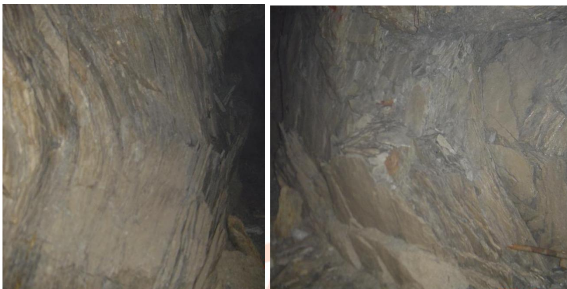
图 2-12 保护墩的溃屈破坏
